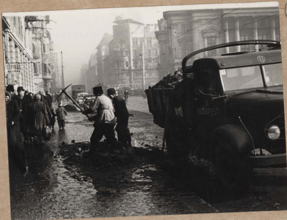
Helyreállítási munkák a Rákóczi uton a Nemzeti Színháznál.
