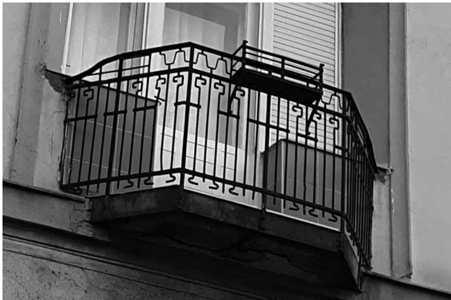
Virágládák elhelyezésére szolgáló erkélykorlát egy 1913-ban épült házban (Budapest, XI. kerület Dombóvári út 1.)
