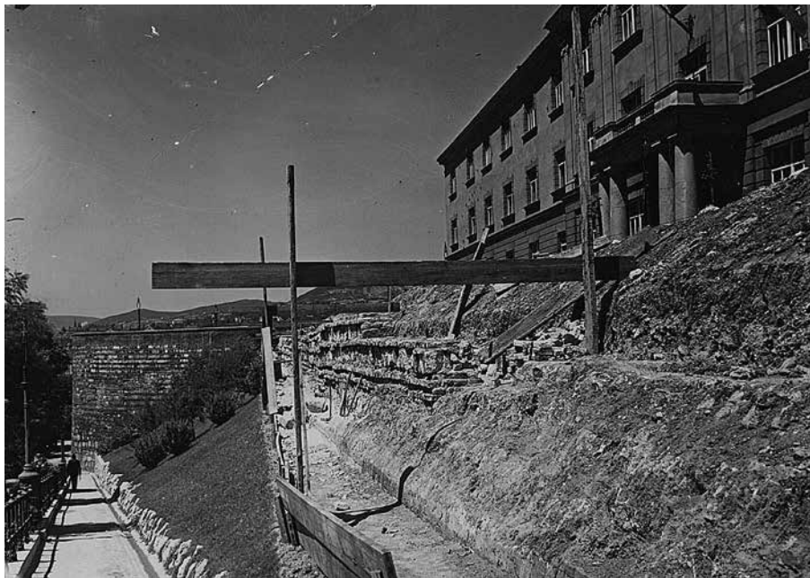
A várfal helyreállítása és a Lovas útra vezető lejtő kiépítése – az épület külső része már elkészült, 1930. augusztus 12. (HTM Fotóarchívum)
