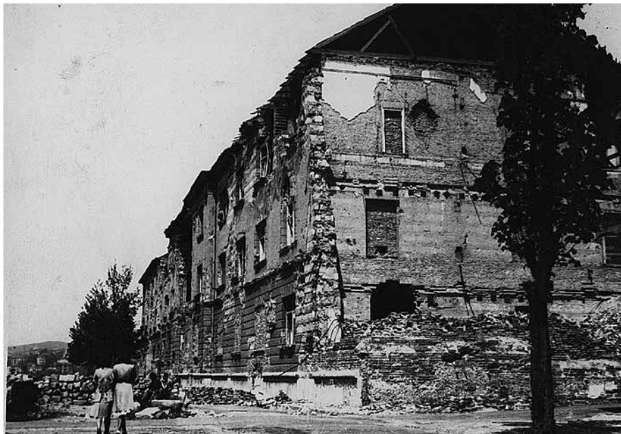
A lebombázott, majd 1945. június 28-án hajnalban leomlott épületrész, a II. emeleti falban a már befalazott könyvtári átjáró ajtóval, jelentős romeltakarítás után
