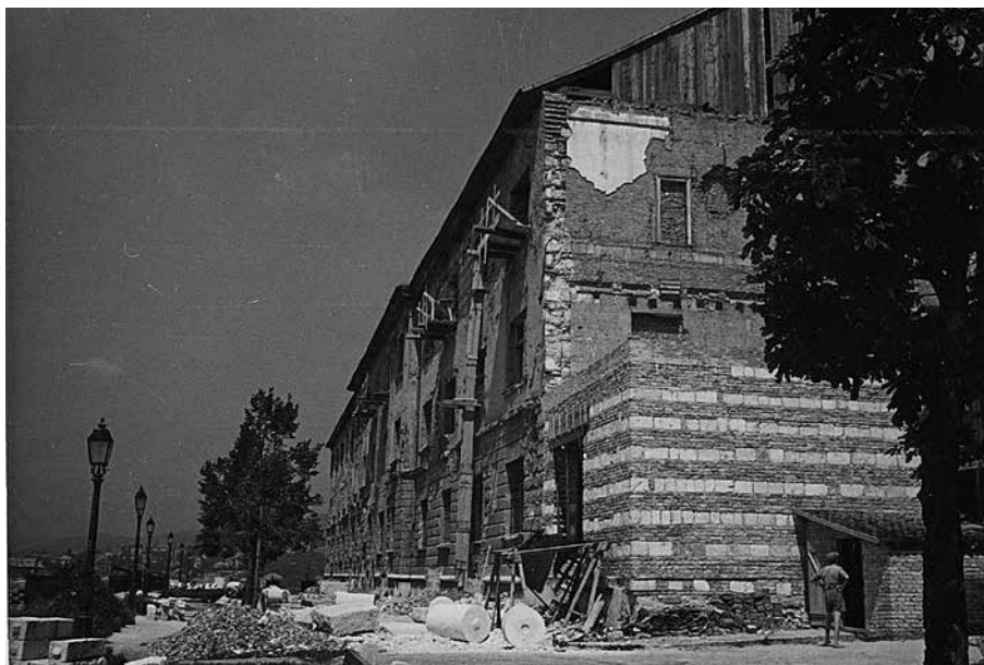
A lebombázott, majd 1945. június 28-án hajnalban leomlott épületrész, a II. emeleti falban a már befalazott könyvtári átjáró ajtóval, jelentős romeltakarítás után és építkezés közben, az igazgatósági tömb helyén már felhúzott első szinttel
